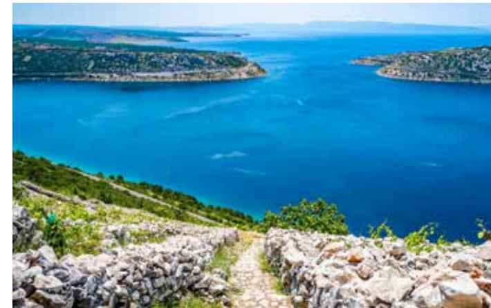
Výstavba impozantných kamenných múrov bez spojivového materiálu sa začala v 18. storočí.
